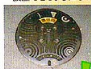
↓ 施設の前面には「震災用」と書かれたマンホールがある。ここには下水道直結式仮設トイレが設置できるようになっている。
